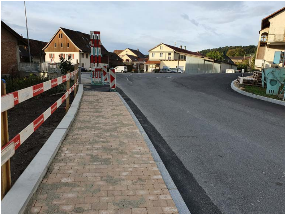
29.10.2023 Le débouché de la route de Fétingny sur la place du Village et le nouveau trottoir en construction
