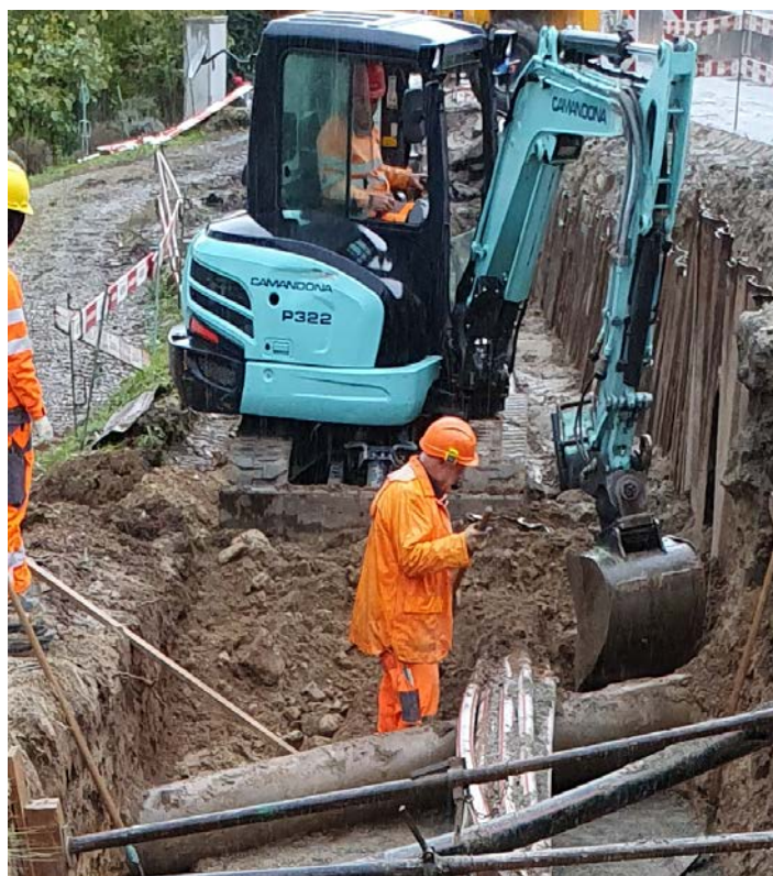
13.11.2023. Travail de précision pour ne pas endommager les conduites qui apparaissent un peu partout.
