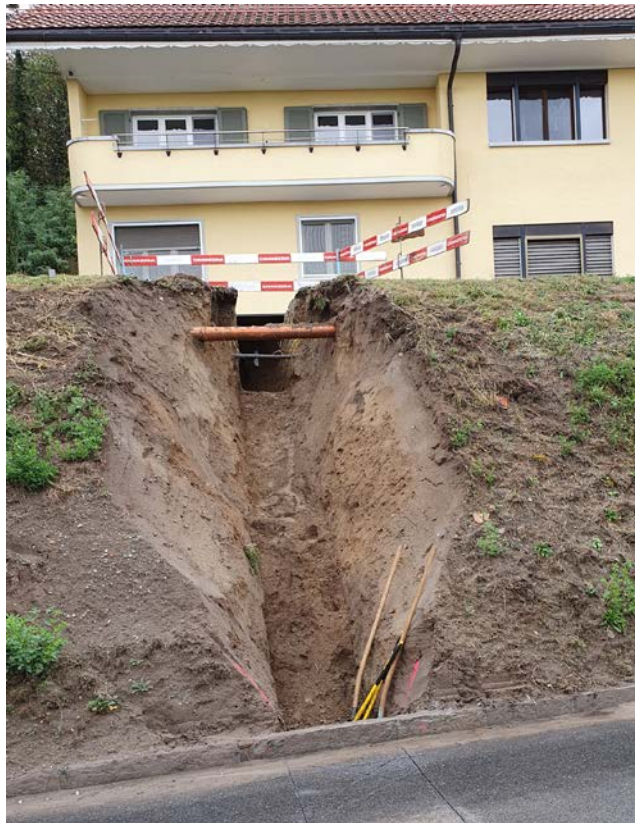
31.10.2023 La tranchée pour l'eau en boucle route de Fétigny – ruelle du Mont
